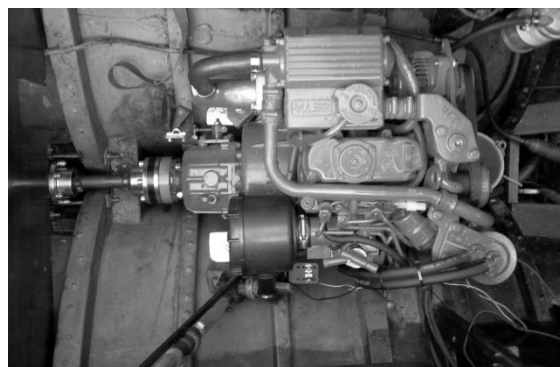
CV-axeln monterad på plats.
