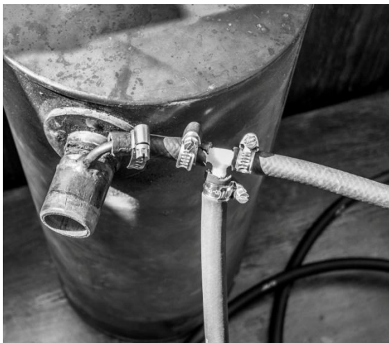
Returledningen kopplades in på avluftningen.
