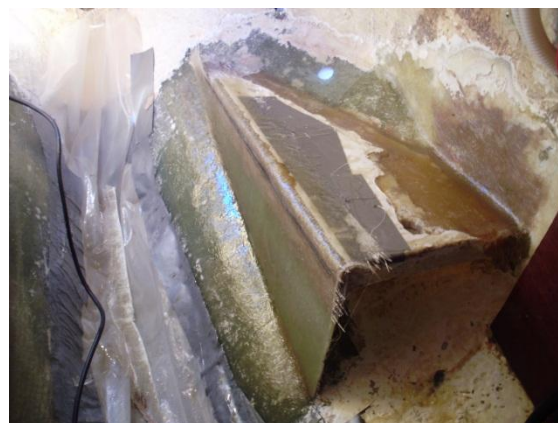
Plastning av sidor på bädden
